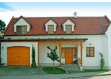
Dem Sektor Sanierung wird im Sinne des Klimaschutzes größte Wichtigkeit zugemessen.
