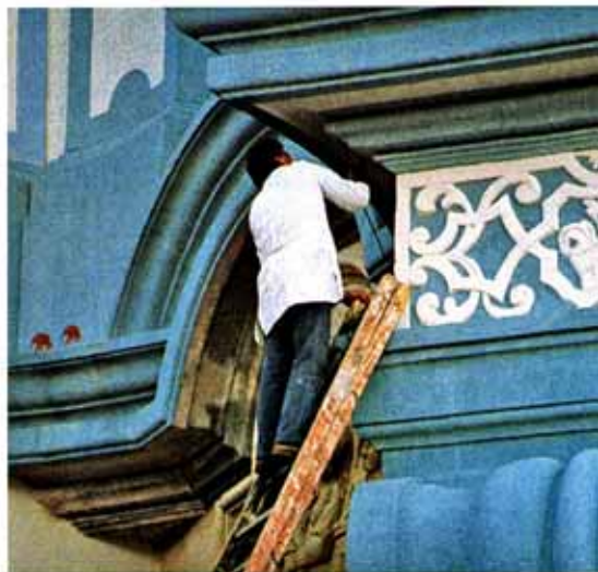
Turmnordseite — letzte Malerarbeiten, 20. Oktober 1986
