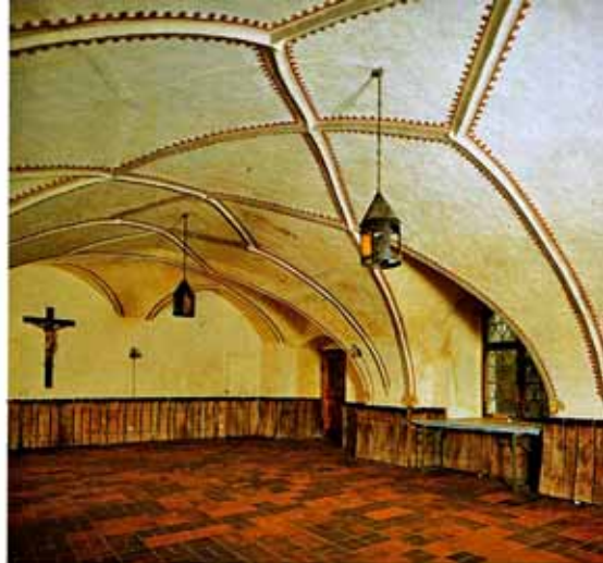
Ehemaliges 2. Refektorium, 16. Jahrhundert
