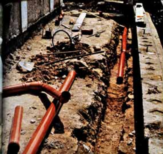
Terrasse, Juli 1986 — Kanalverlegung
