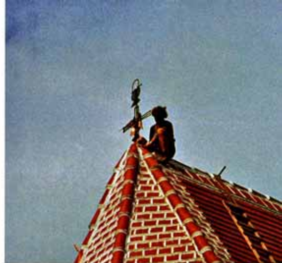
Anarbeiten der Walmkappe
