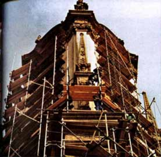
Eingerüstung des Turms, April 1986
