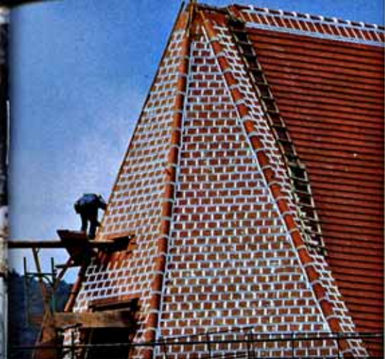
Presbyterium — Vermörtelung laut Original
