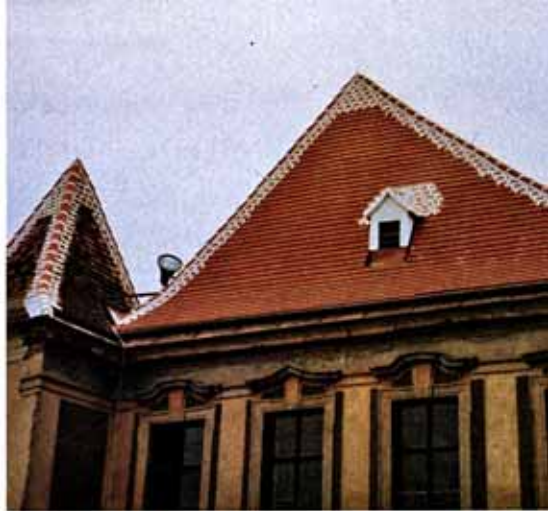
Saaldach, nach Fertigstellung, August 1986
