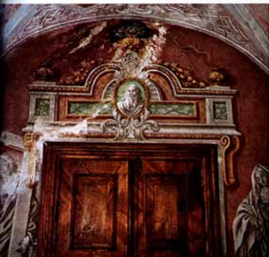
Oratorium — Wandmalereien, Originalzustand
