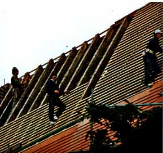
Kirchensüdseite — neue Lattung
