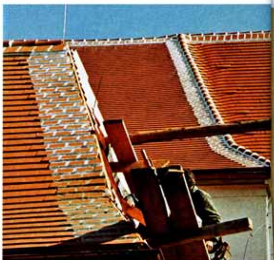
Südseitige Dächer, Kreuzgang — Kirche
