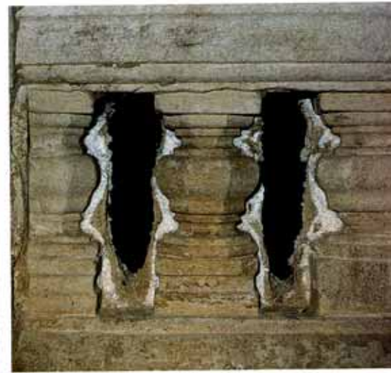
Krypta — Balustrade, Kompressen bei der Abnahme
