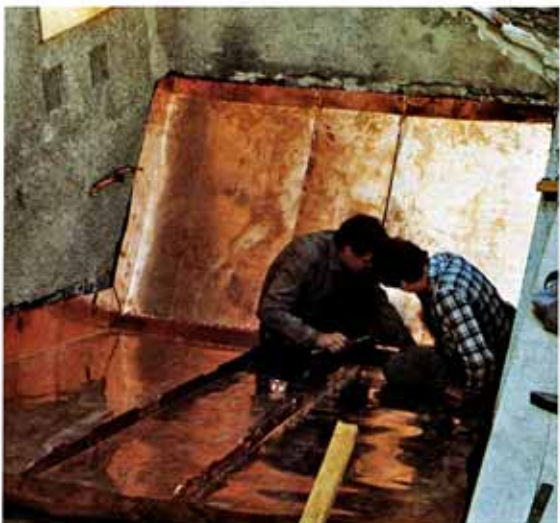
Sakristeistiege — Blechdeckung
