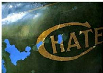
Tankkörper, Detail aus dem Schriftfeld, während der Restaurierung. Mit Berliner Blau eingefärbte Kittung als Untergrund für die Retusche.
