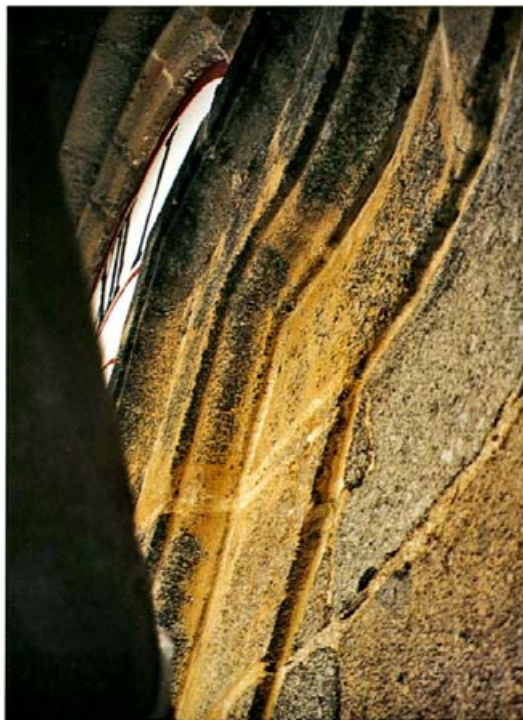
Färbelungsreste an geschützten Teilen der Turmfassade (hier vor allem die Ockerfärbung von 1850)
