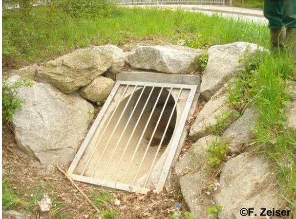
**RICHTIG: Schräg liegende Gitter als Alternative - Material wird durch abfließendes Wasser hochgedrückt und kann Durchlässe nicht verklausen (Ausführungen mit Scharnieren ermöglichen schnellen Zugang zum Durchlass)**
