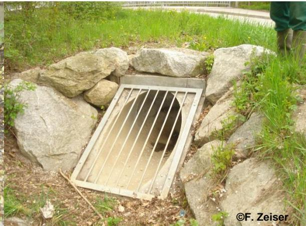
**RICHTIG:** Baustahlgitter verwehrt Bibern den Zugang zu einem Durchlass (Links); Schräg liegende Gitter als Alternative - Material wird durch abfließendes Wasser einfach hochgedrückt und kann Durchlässe nicht verkleuen. Ausführungen mit Scharnieren ermöglichen schnellen Zugang zum Durchlass (Rechts)
