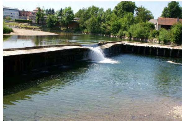
Abbildung 74: Schäden Bruckmühle Mai 2011
