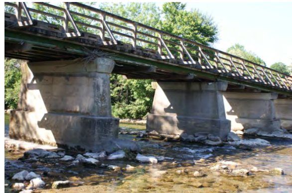
Abbildung 83: Eintiefung Brückenfundamente
