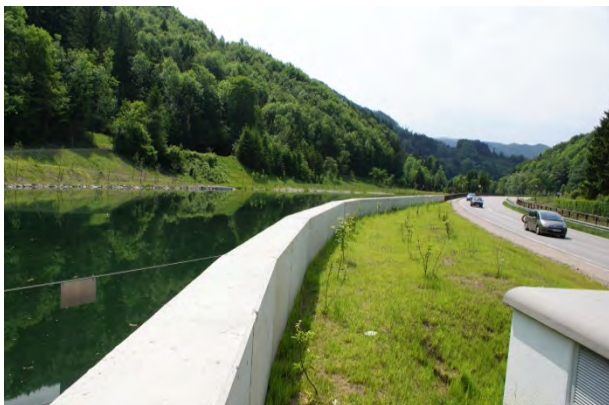
Abbildung 40: Stauraum KW Neubruck
