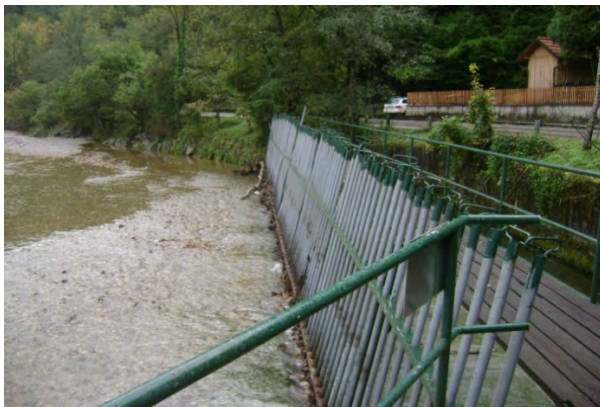
Abbildung 24: Heiserwehr Sept. 2010, Einlauf verlegt
