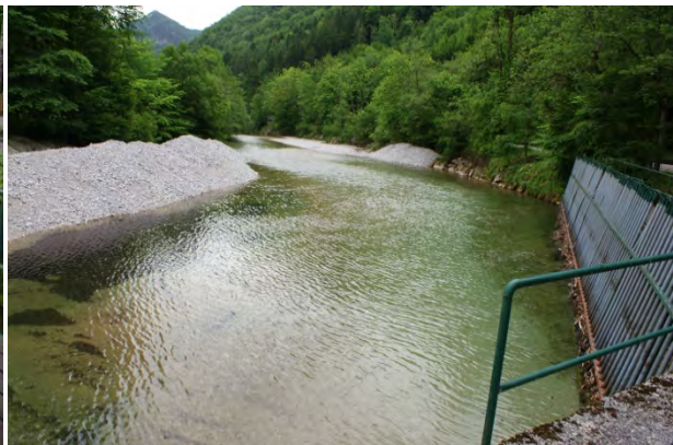
Abbildung 25: Heiserwehr Mai 2011, nach Baggerung
