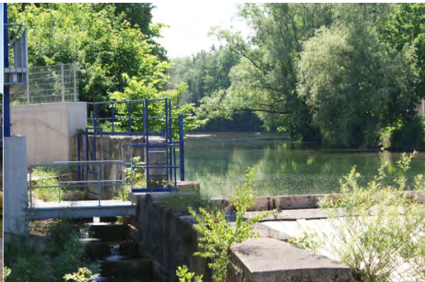
Abbildung 69: Staubereich Wehr Zizala
