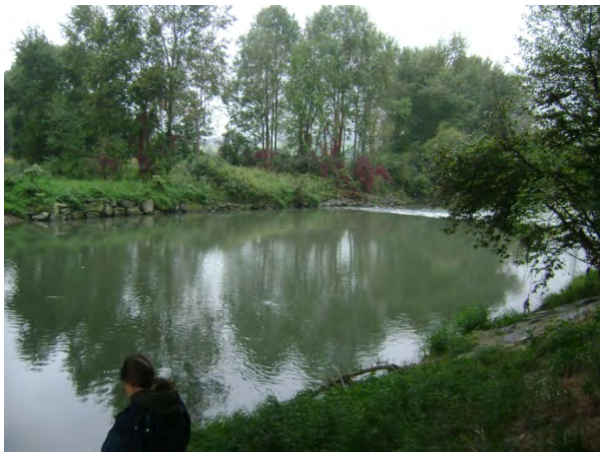
Abbildung 89: Sohlrampe unterhalb km 5.00
