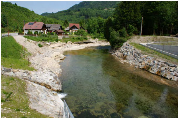
Abbildung 42: Rückstau bachab der Wehranlage Neubruck
