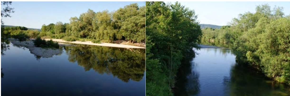
Abbildung 97: Geschiebeablagerung unterhalb Wehr Neuda Abbildung 98: Werkskanal Neuda vor der Ennsmündung
