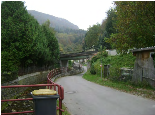
Abbildung 20: Verbauter Unterlauf Lueggraben
