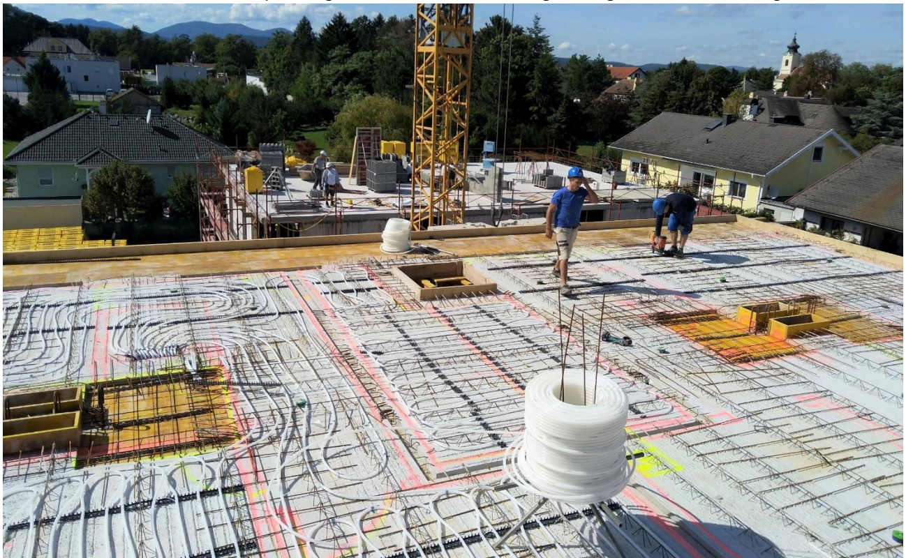
Grafik 24: Theresienfeld Tonpfeifengasse – Bauteilaktivierung, verlegte Kunststoffleitungen
