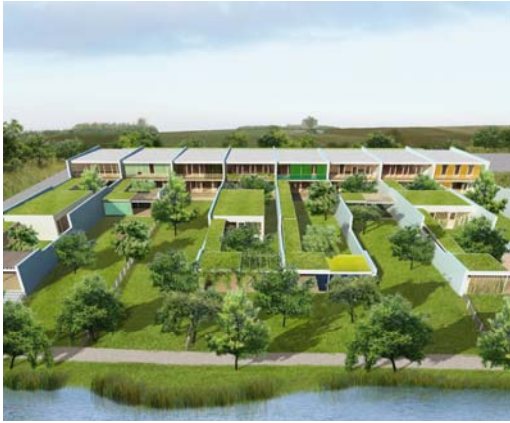
In Neupölla entsteht ein zukunftsweisender Fertigteilwohnbau in verdichteter ökologischer Bauweise. © raith nonconform architektur vor ort
