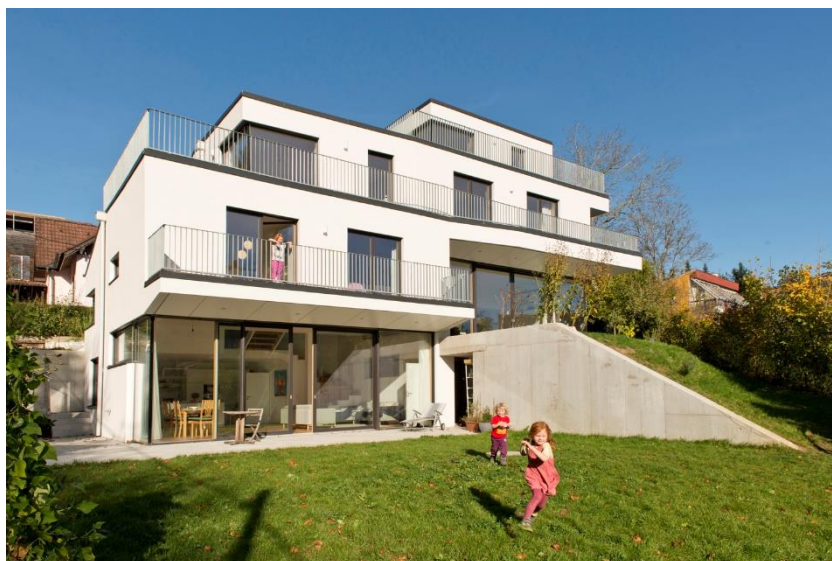
Abbildung 2: Doppelhaus in Purkersdorf, das mit thermischer Bauteilaktivierung und prädiktiver Steuerung ausgestattet ist [8]
