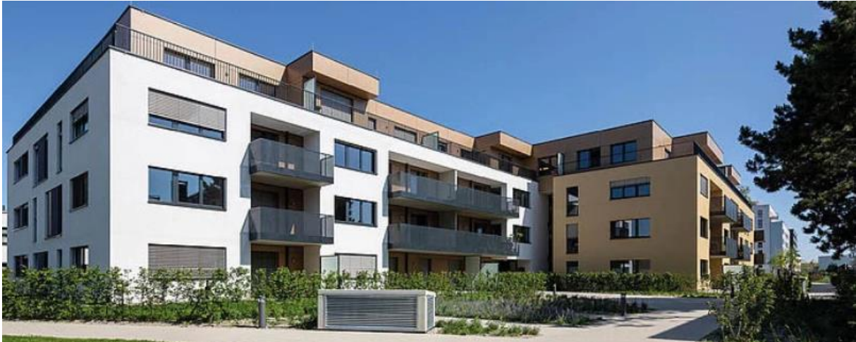
Abbildung 3: Wohnbau mit thermischer Bauteilaktivierung in der Kugelmanngasse 1A [9]
