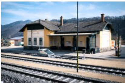
Pünktlich zum Saisonstart der Wachaubahn wurde der barrierefrei gestaltete Bahnhof Aggsbach Markt eröffnet.
